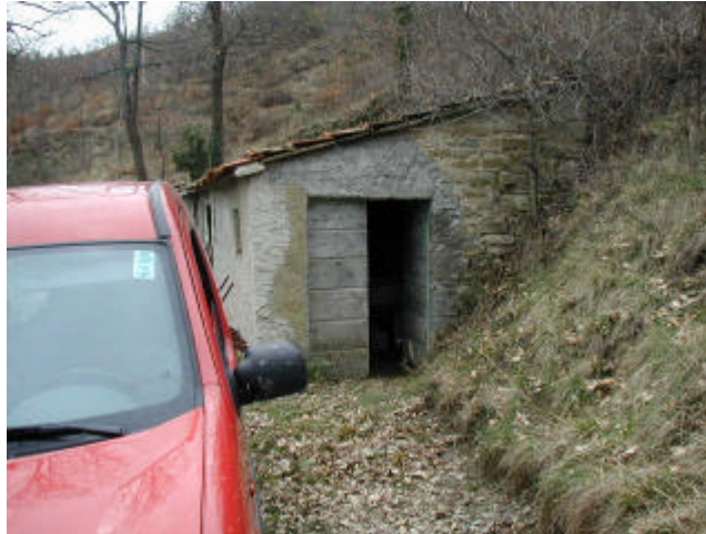
Esempio di Installazione Stazioni Rete Sismica Temporanea
