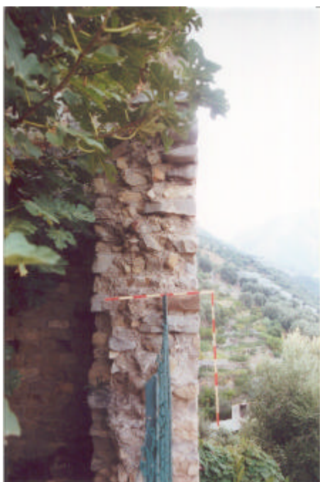
Figura 4.1.3. Sezione a due paramenti.
