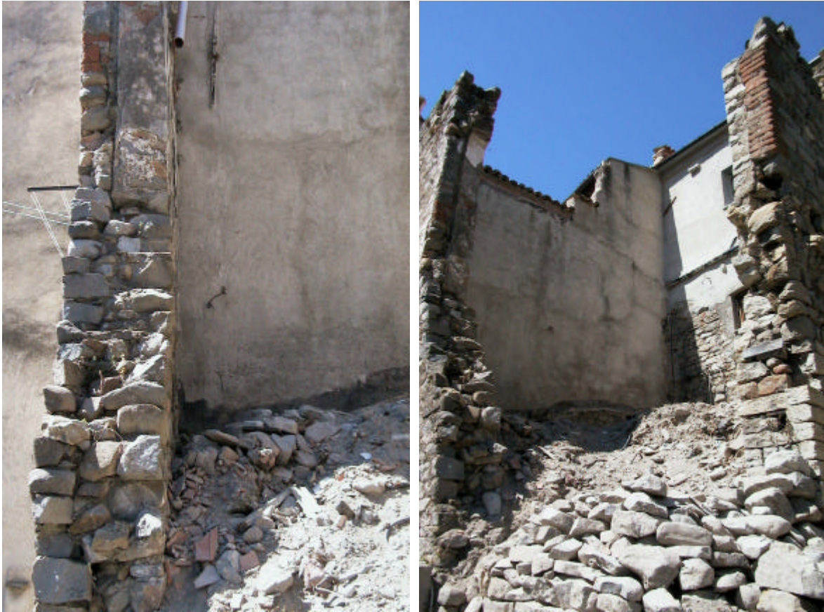
Figura 4.2.9. Taggia: qualità dell'ingranamento delle pietre presso la fontana medievale.
