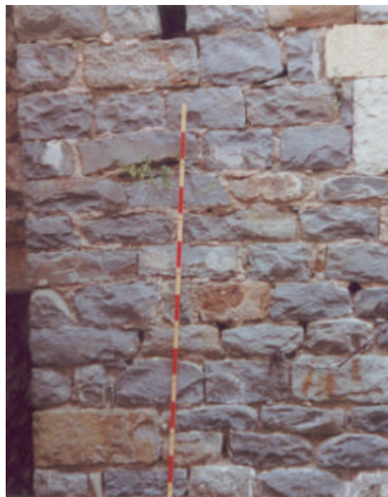
Figura 4.1.2. Tessitura muraria a corsi regolari
