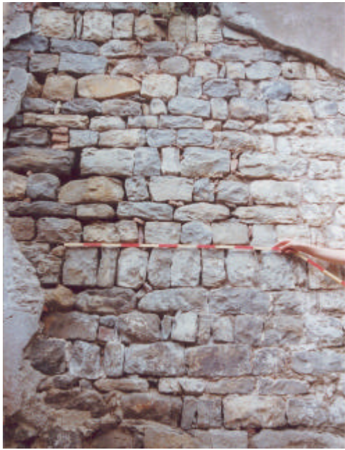
Figura 4.1.6. Corsi suborizzontali con ricorsi.
