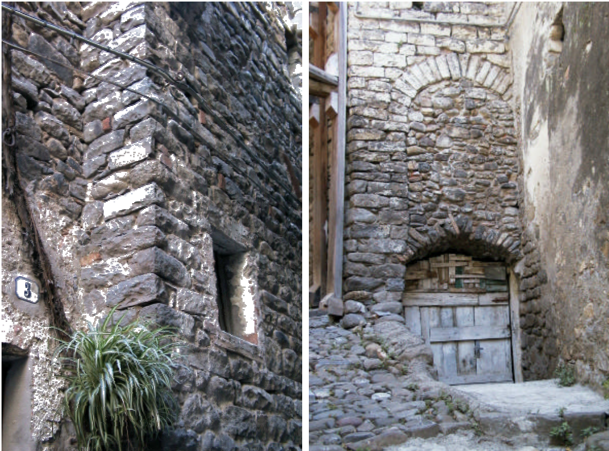
Figura 4.2.6. Taggia: murature di ottima tessitura squadrate o sbozzate.
