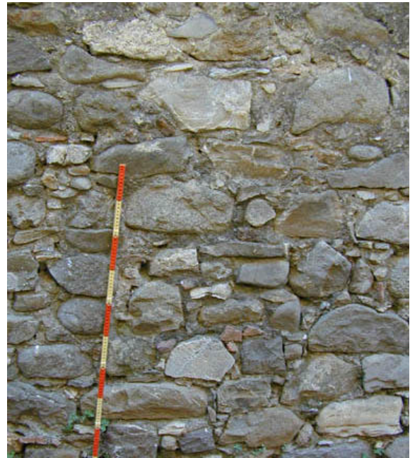
Figura 4.1.7. Tessitura muraria a corsi irregolari.
