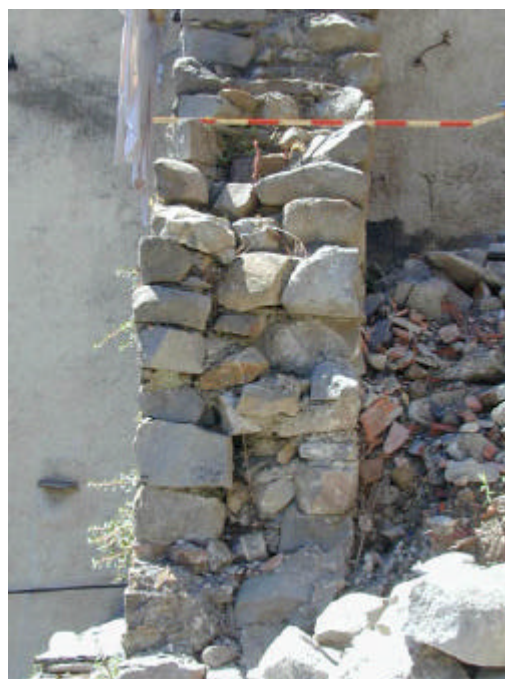
Figura 4.1.4. Sezione a tre paramenti.
