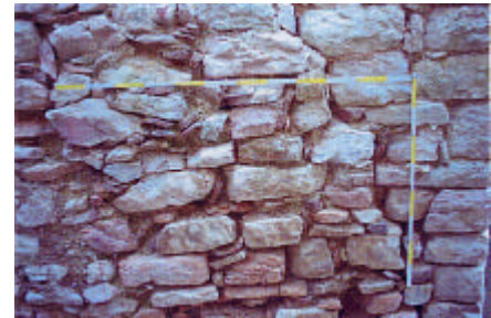
fig. 13 – Tessitura muraria a corsi irregolari
