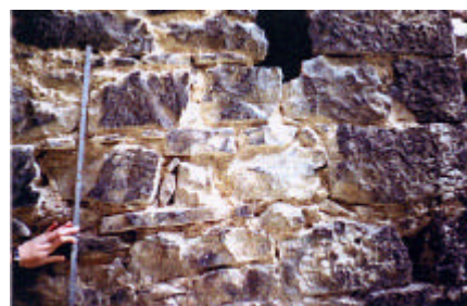
fig. 12 – Tessitura muraria a corsi suborizzontali
