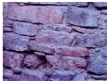
fig. 11 – Tessitura muraria a corsi suborizzontali
