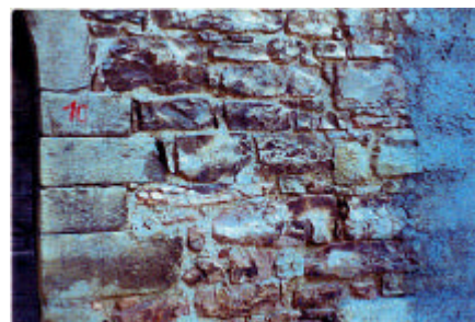
fig. 10 – Tessitura muraria a corsi regolari
