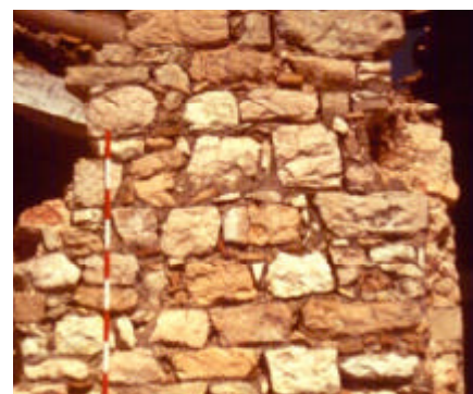
fig. 8 – Tessitura muraria a corsi suborizzontali
