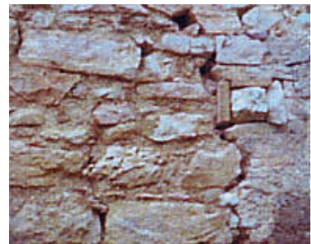
fig. 14 – Tessitura muraria a corsi irregolari
