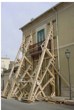
Figura 6. Puntello su due livelli (Molise 2002)
