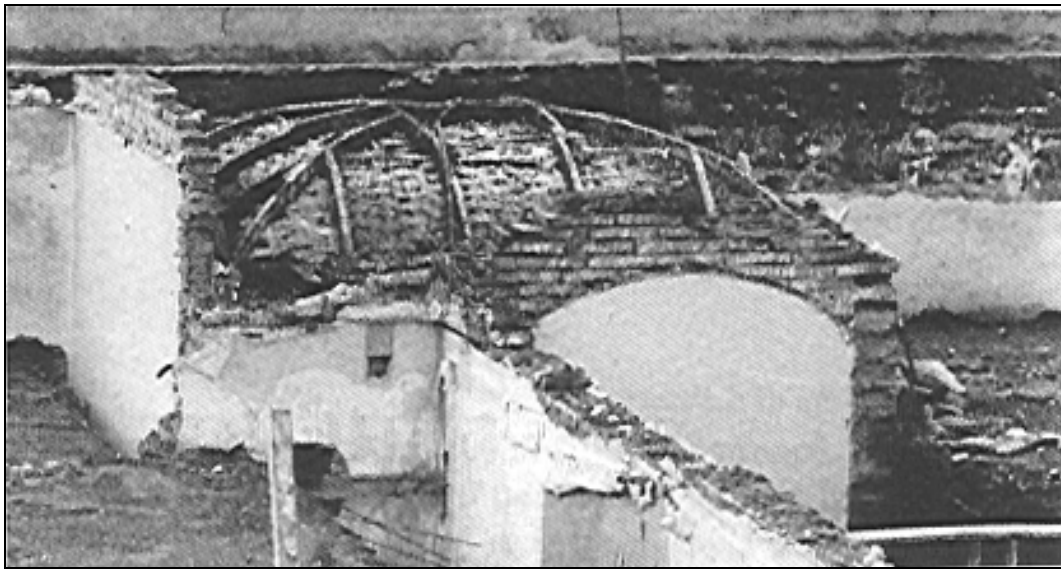
Fig. 1.18 - Estradosso di una volta "finta" (Randazzo 1988).
