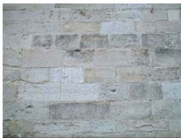
Facciata - zona centrale
