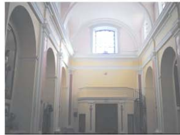
Aula — lato facciata
