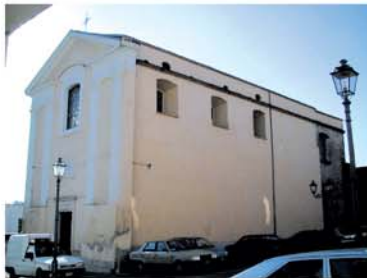
Facciata e prospetto laterale
